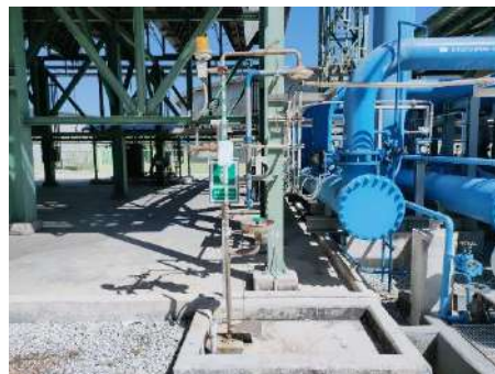
ภาพที่ 2.2-23 อ่างล้างตาฉุกเฉินและร่างกาย
