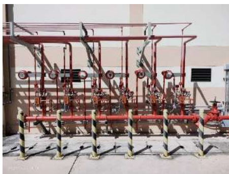
ภาพที่ 2.2-25 อุปกรณ์ตรวจวัดความดัน
